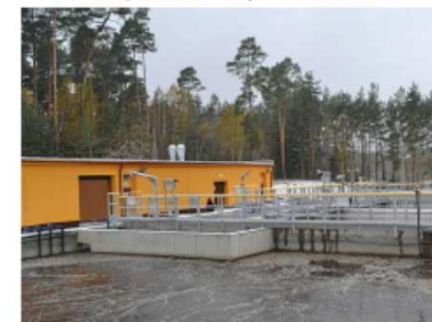
ČOV Hradčany. Foto: Syner s.r.o
