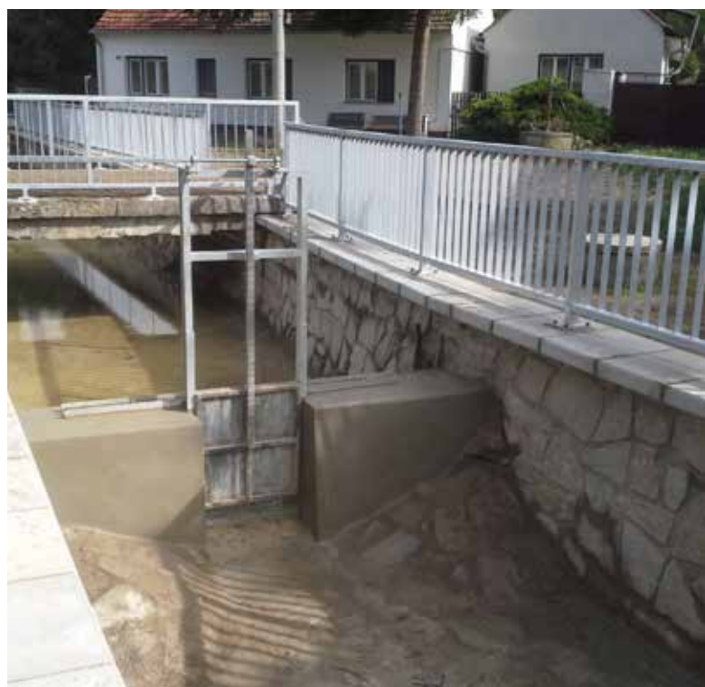
↓ V červenci po provedené opravě
