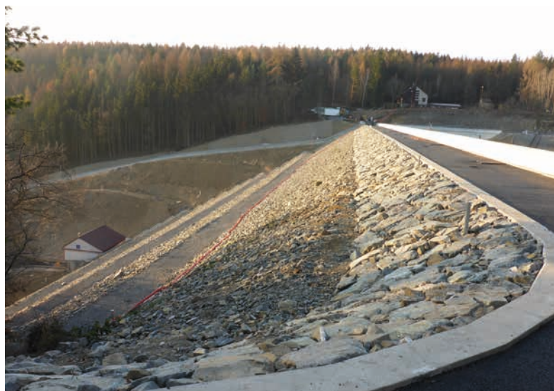
Pohled na upravený vzdušný líc nádrže, listopad 2018 ↑
