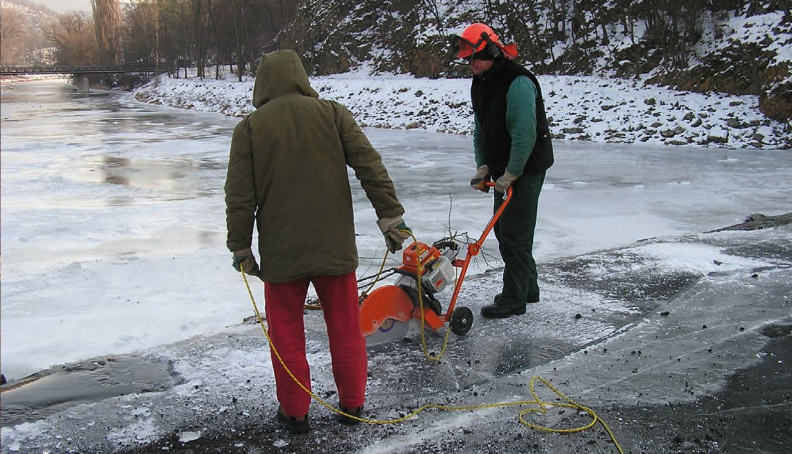
Odfezávání ledu pomocí motorové pily na led, Jihlava, leden 2009 ↑ Rozmrazování stavidel na Strhanci, rok 2010 ↓
