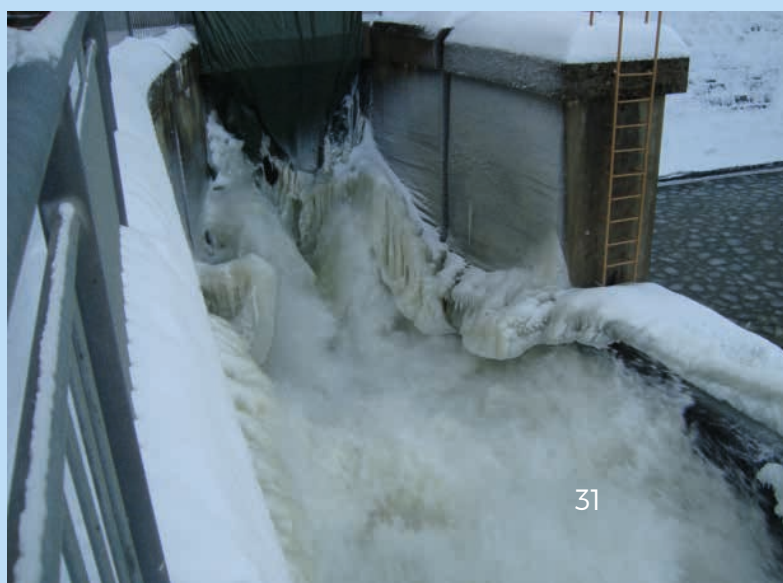
Zámraz spodní výpusti VD Brno ↓
