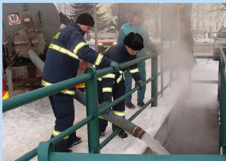
Odfezávání ledu pomocí motorové pily na led, Jihlava, leden 2009 ↑ Rozmrazování stavidel na Strhanci, rok 2010 ↓
