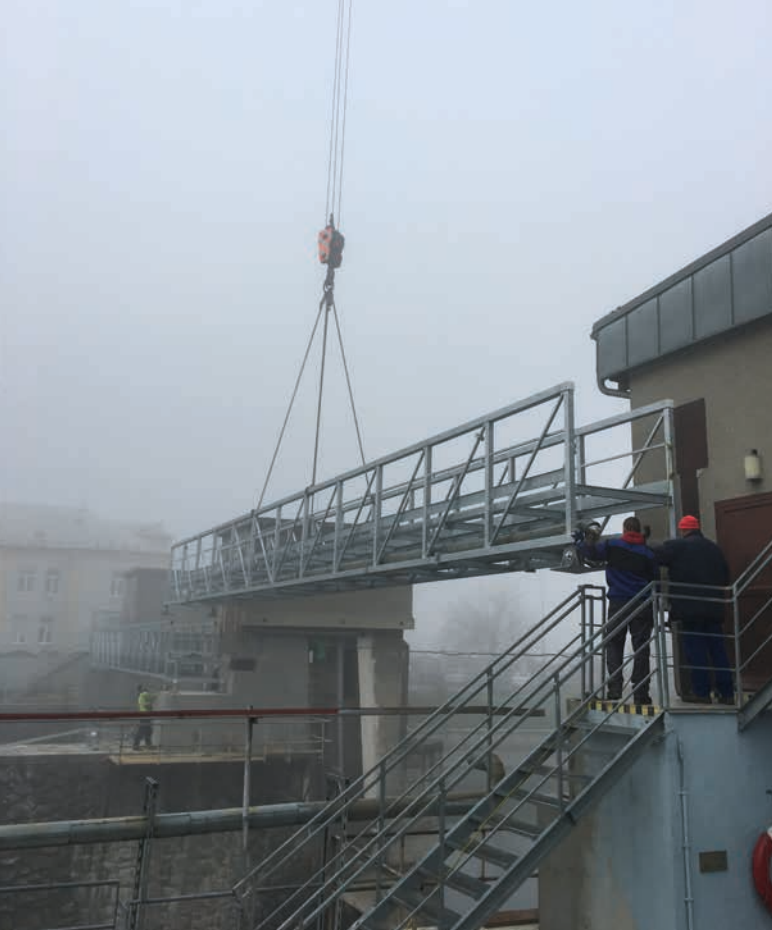
↑ Osazování druhého pole manipulační lávky jezu Olomouc
