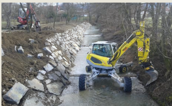
↑ Oprava pravobřežní nátrže v Bystřici pod Hostýnem
