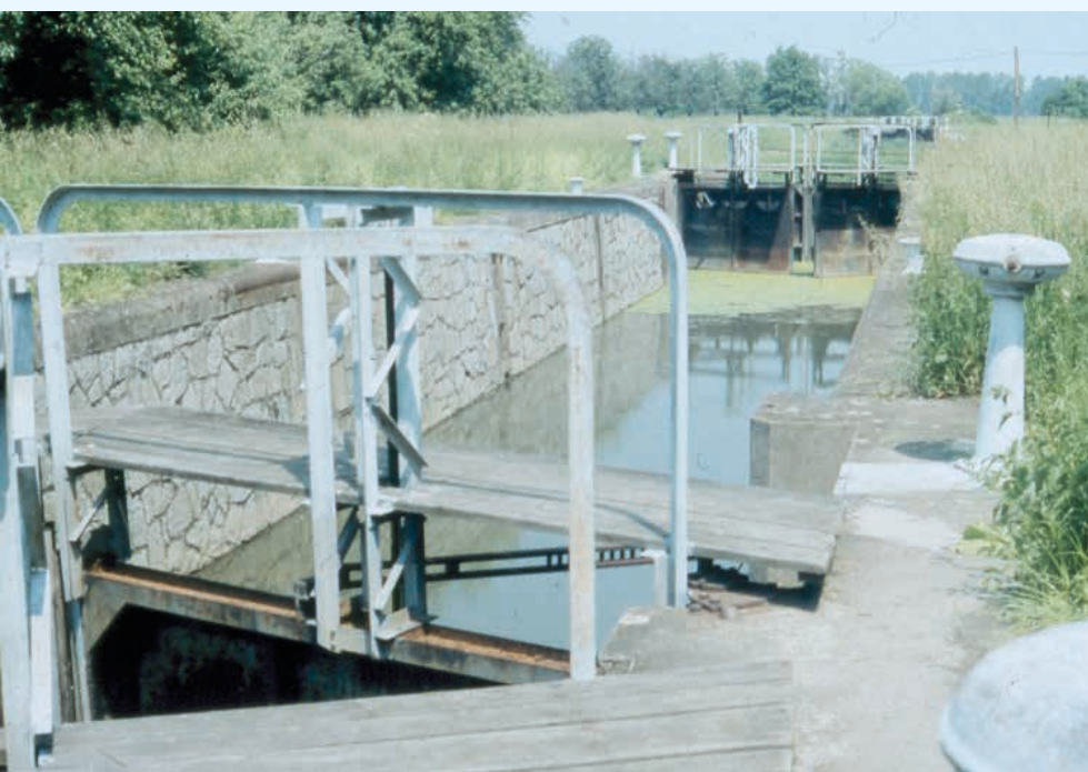
← Plavební komora Strážnice před obnovou
