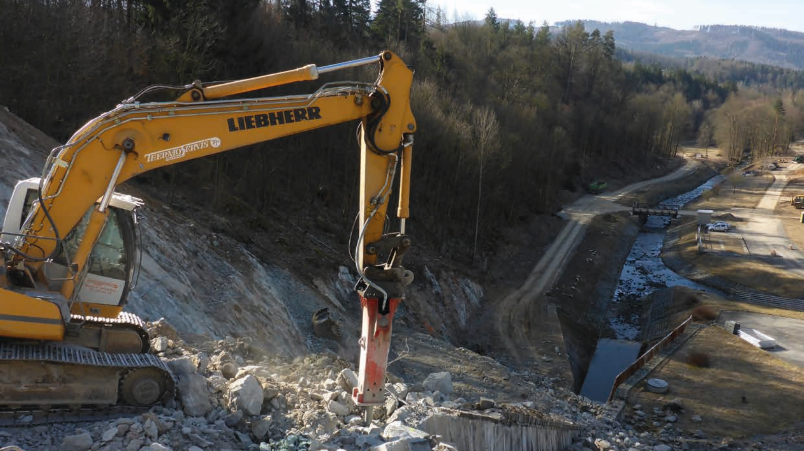
Bourací práce na skluzu VD Boskovice – březen 2018 ↑
