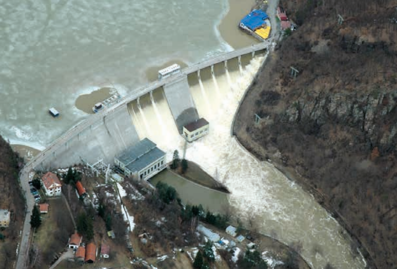
↑ VD Vranov při převádění povodně v březnu 2006
