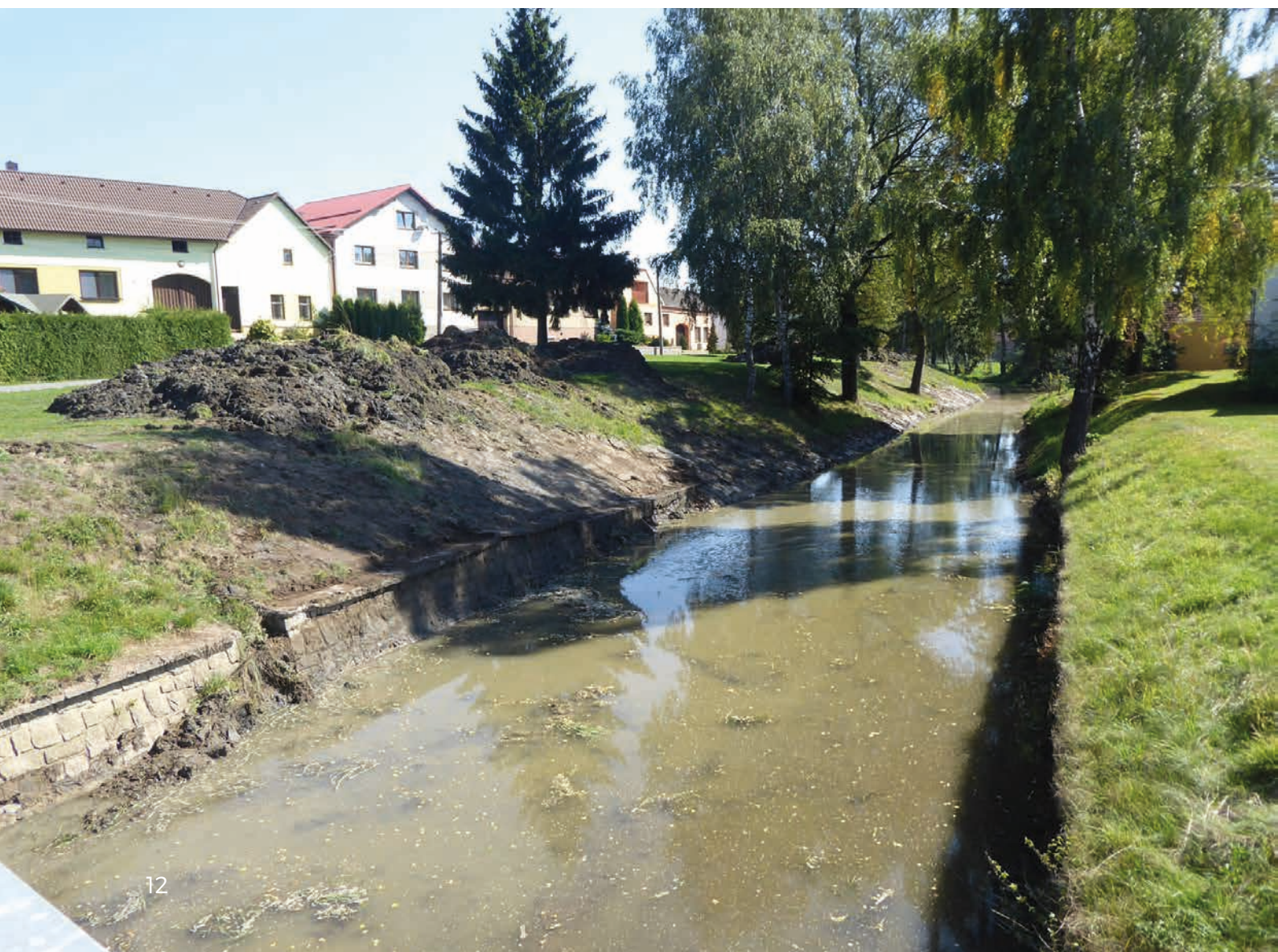
Řeka Oslava v Sazomíně před těžbou nánosů... ↑ ... a po provedeném vyčištění ↓
